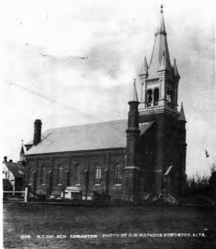
Photo 2 Eglise Saint-Joachim, Edmonton, 1899. (PAA)
